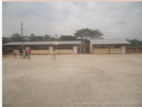
Foto 26. Escuela de El Guasmo.
