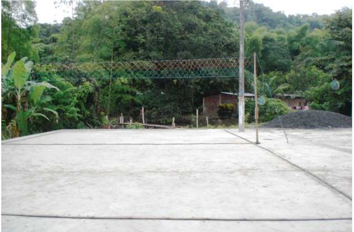
❖ Construcción de cancha de vóley en el Barrio El Progreso.
