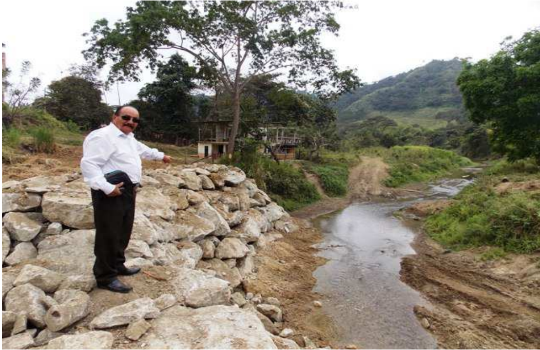
❖ Construcción de muros de escolleras en el Barrio El Progreso.
