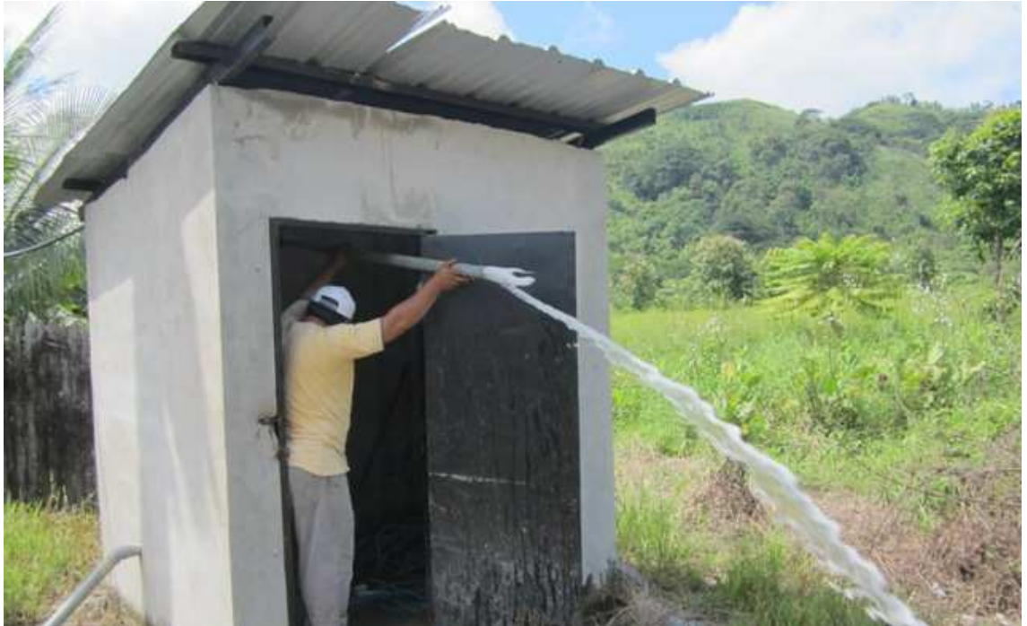
❖ Instalación de dos grupos hidráulicos de 5 HP en pozos de agua en la vía Pajarito, instalación de bomba de captación en el Río Puca del Cantón Olmedo.
