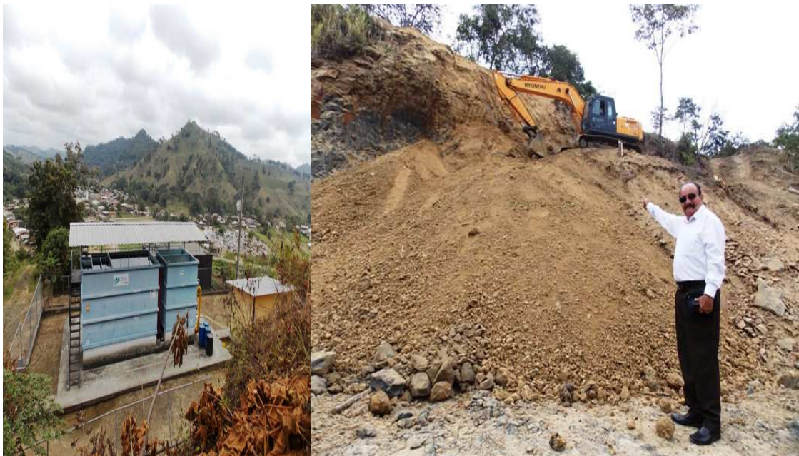
❖ Construcción de protección de la planta de potabilización de agua en el Cerro La Turena.
